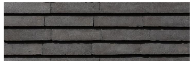
Skærmtegl lagt som klinkbeklædning
